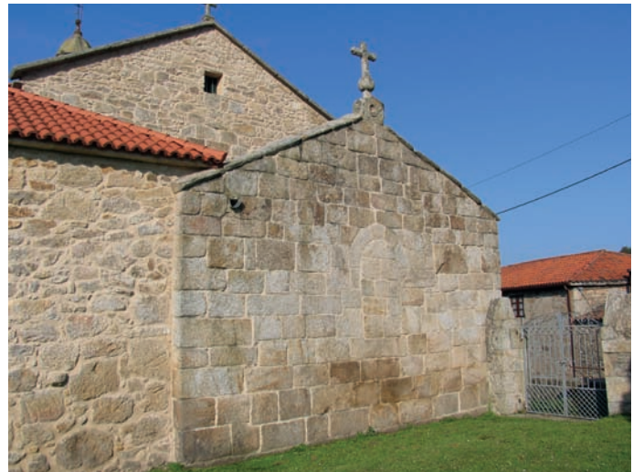
Muro este de la cabecera
